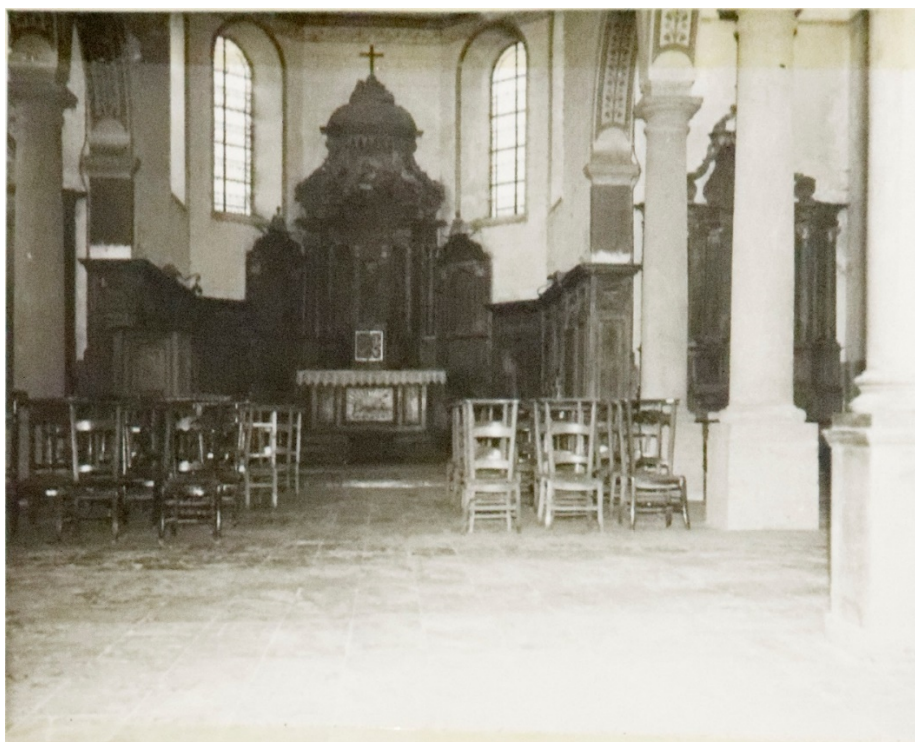
Figure 8. En 1964, maître-autel. À droite, derrière les piliers, on devine l'autel latéral droit.
